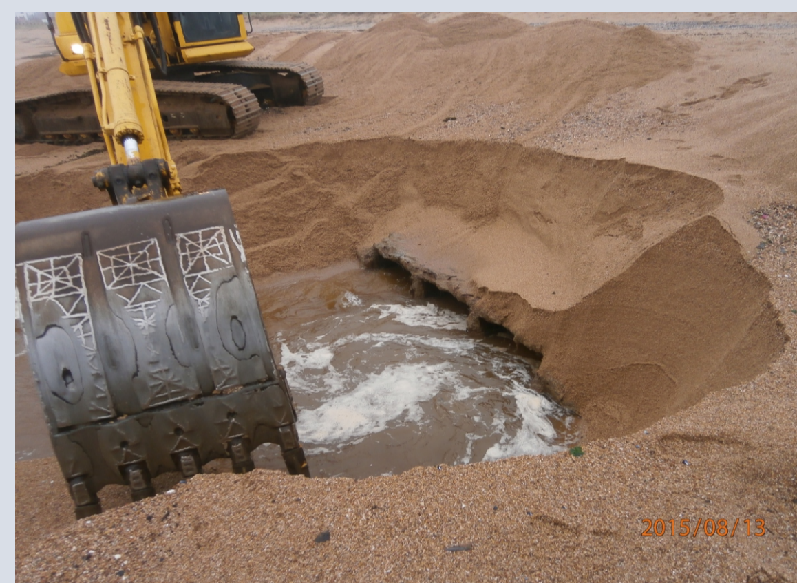
Apertura de la salida al mar de la Laguna del Diario, se observa la máquina realizando el procedimiento de apertura.
