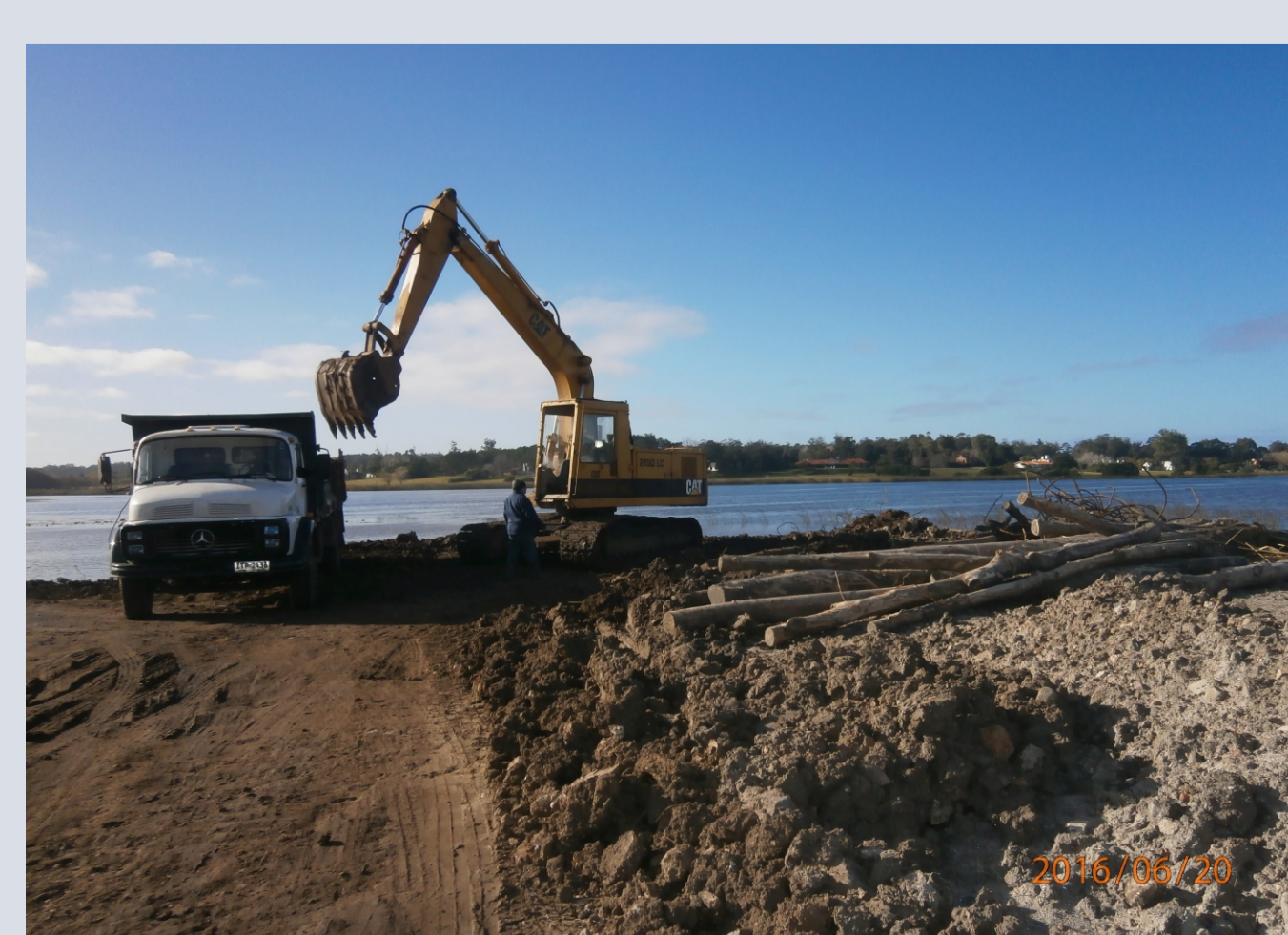
Remoción de terraplén.
