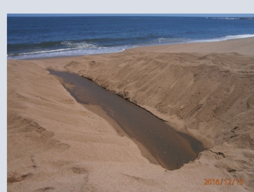
Salida de la alcantarilla
