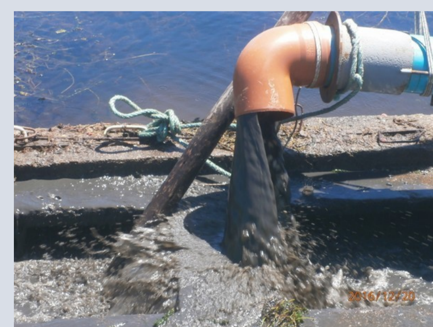
Salida de la alcantarilla
